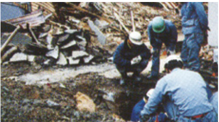
瓦礫の中での復旧作業（阪神・淡路大震災）
