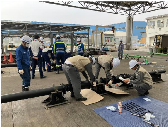
配管の接合訓練
