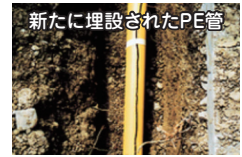
新たに埋設されたPE管
