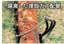
腐食した埋設ガス配管
